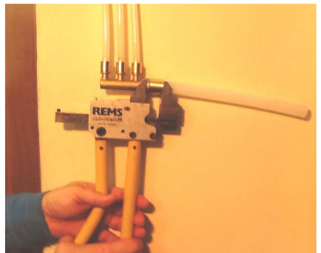
13.b. ábra a sajtoló szerszám használata
