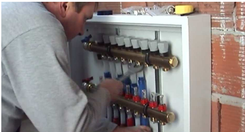
8. ábra: a nagy osztó-gyűjtő beszerelése
